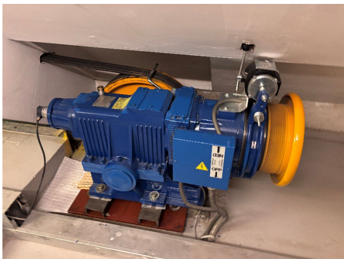
Figur 3: Heismotor må tappes for olje før demontering
