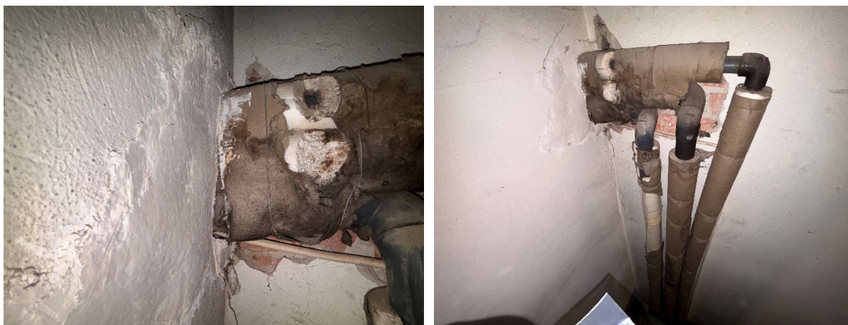
Figur 5: Rørgjennomføringer kan inneholde hylser med asbestholdig rørisolasjon
