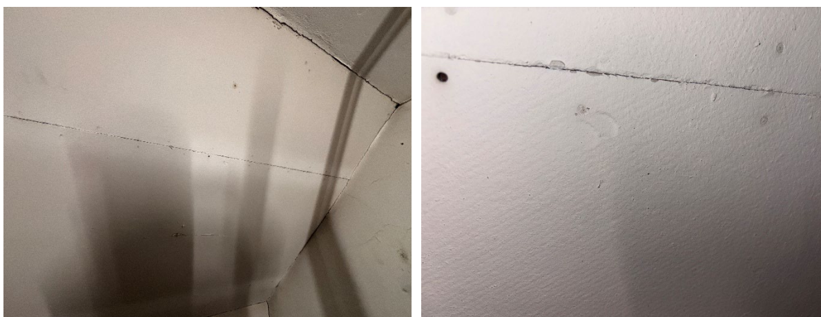
Figur 4: Asbestoluxplater i heissjakten må asbestsaneres
