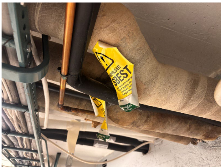
Figur 6: Merket rørisolasjon i kjellerareal
