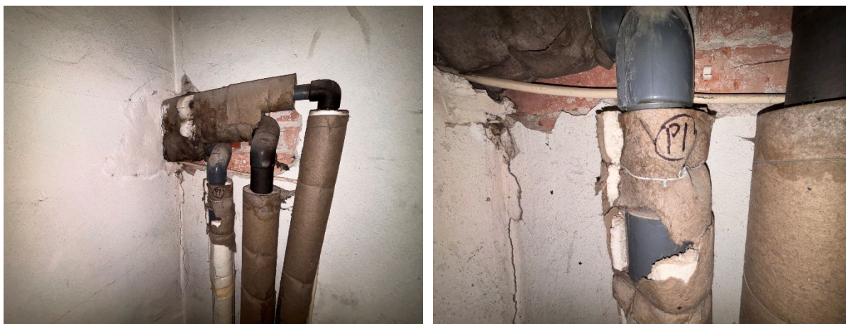
Figur 7: Grå rørpapp i heissjakten inneholder ikke asbest
